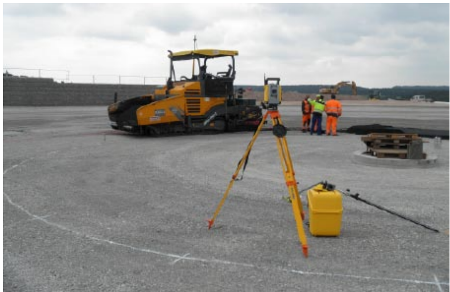
Do dokładnego ułożenia asfaltu wykorzystano system sterowania Trimble PCS900 Paving Control System
