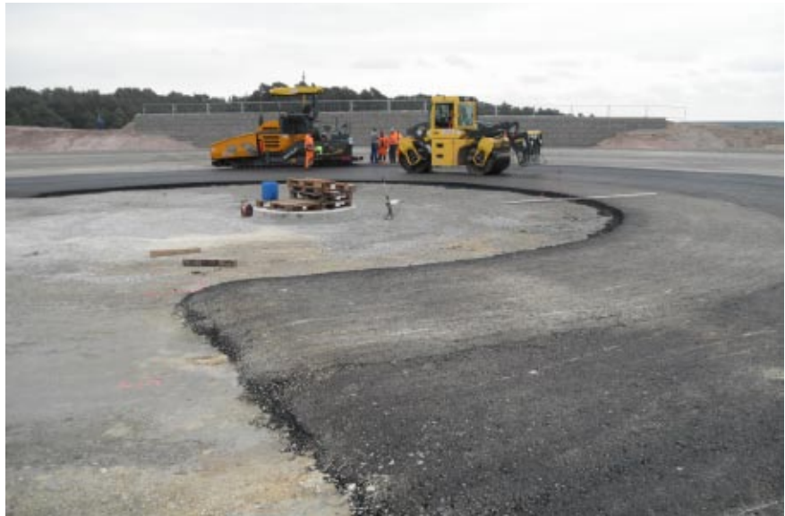
Układanie asfaltu w półkolach rozwiązało problem dostawy materiału do rozścielacza
