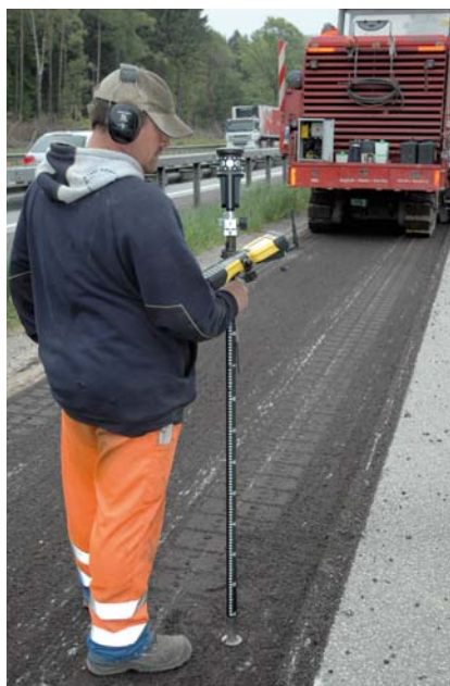
Operator urządzeń ABS Sven Ungnade podczas kontroli frezowanej nawierzchni
