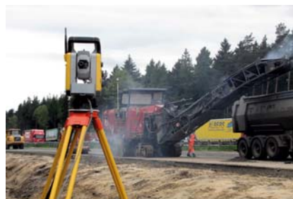
Profilowe frezowanie powierzchni przy wykorzystaniu kontrolera Trimble 3D, prace na autostradzie A1 Hamburg – Brema
